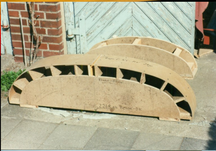
Bogensegmente für den Eingangsbereich (Bauhandwerkerhilfe)
